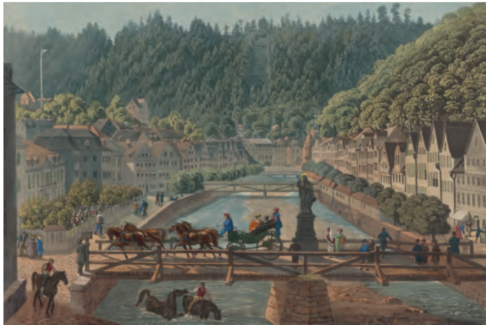
Carlsbad. Promenade auf der alten und neuen Wiesengasse / Carlsbad. Promenade on old and new Wiesengasse. Eduard Gurk, um / ca. 1825/1830.
